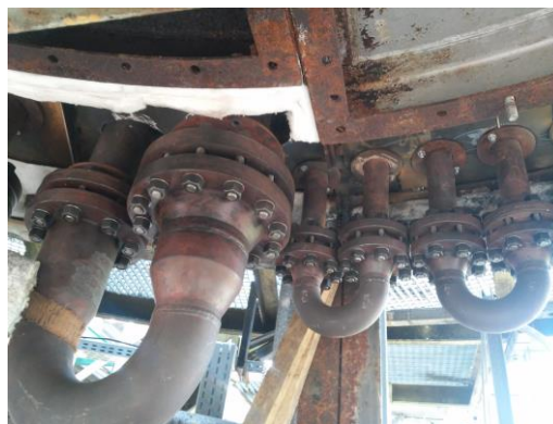
Returbenty dolne wymiennika radiacyjnego
