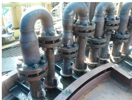
Returbenty górne wymiennika radiacyjnego
