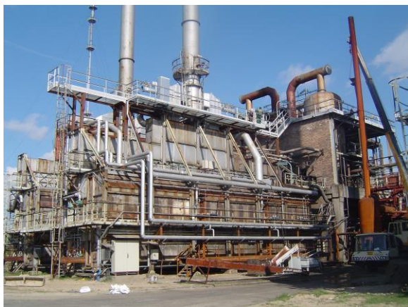
Rys. 1 Piec do syntezy CS 2 po modernizacji
