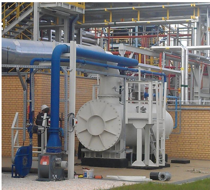
Rys. 1 Dopalacz gazów zrzutowych
