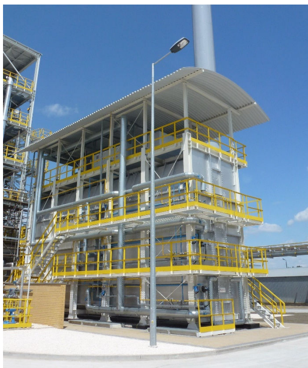
Rys.1 Piec do odparowania ciekłej siarki
