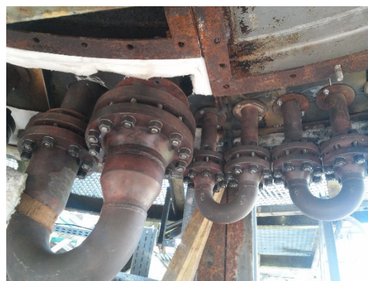
Returbenty dolne wymiennika radiacyjnego
