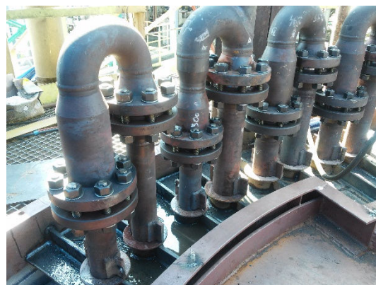
Returbenty górne wymiennika radiacyjnego
