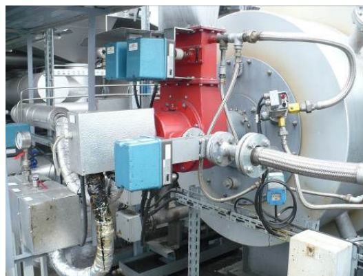
Palnik gazowo-smołowy z zapalarką i nadzorem płomienia
