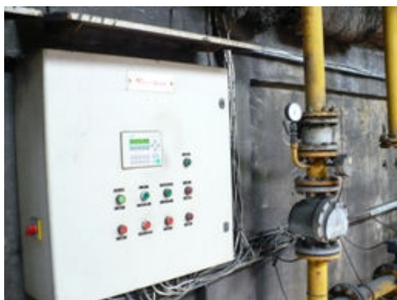
Fot. 4 Szafa sterownicza palnika
