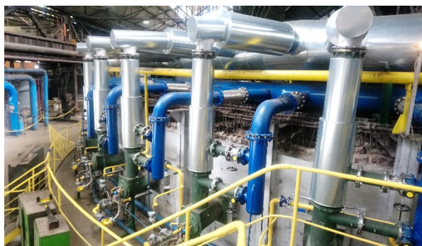
Rys. 4. System grzewczy pieca z obrotowym trzonem o średnicy podziałowej 13,6 m po modernizacji w 2019r.
