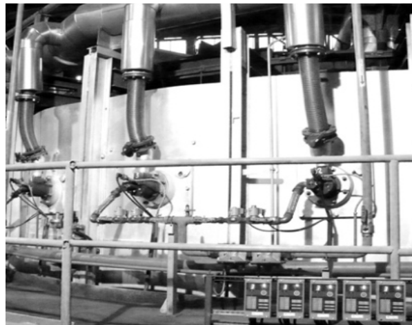
Rys. 2. System grzewczy pieca z obrotowym trzonem o średnicy podziałowej 6, 5 m po modernizacji w 2005r.
